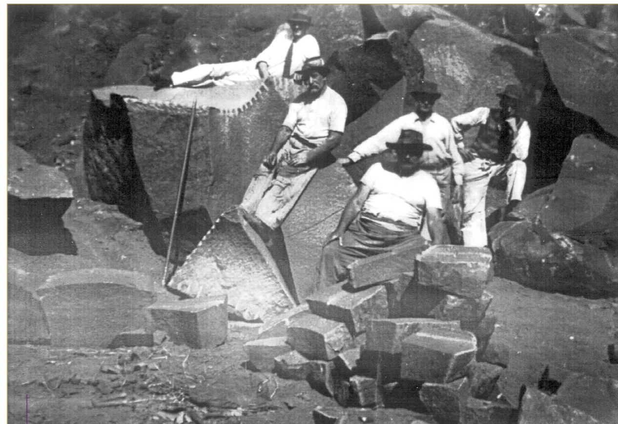
EXTRAÇÃO DE PEDRA E PRODUÇÃO DE PARALELEPÍPEDOS para calçamento de ruas, em 1950 Acervo Particular de Luiz Carlos de Lima
