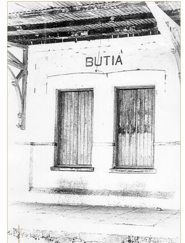
O DÍSTICO DA ESTAÇÃO, com suas janelas fechadas
