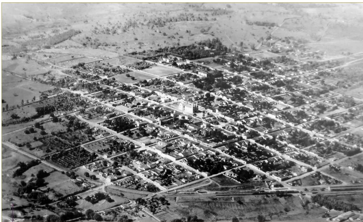
NÚCLEO URBANO DE DESCALVADO EM 1939. Observa-se, à esquerda da Igreja Matriz, dois grandes quarteirões vazios. O primeiro deles onde, posteriormente, foi construído o Ginásio Estadual de Descalvado, atualmente Escola Estadual “José Ferreira da Silva”. O segundo, logo acima, como área residencial Acervo Particular de Luiz Carlos de Lima
